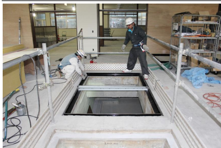
新校舎地下室への入口。地下室の備蓄庫には全児童の2日分の食糧(3年保存)と水(5年保存)、簡易寝袋が収められており、万が一の場合に備えられている。
