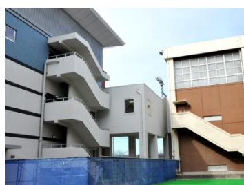
記念体育館との連絡通路
