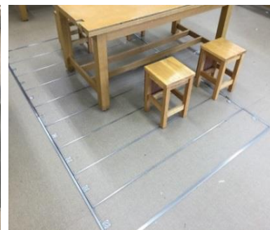
【写真①】一部分だけ違う床
